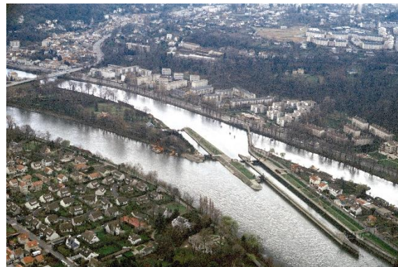
Site du projet de centrale hydroélectrique à Bougival (78) Crédit photo Driea Gobry 2014
