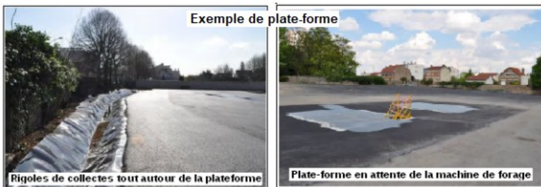
Illustration n° 9 : Exemple de préparation des plateformes de forage – Source DRIEE
