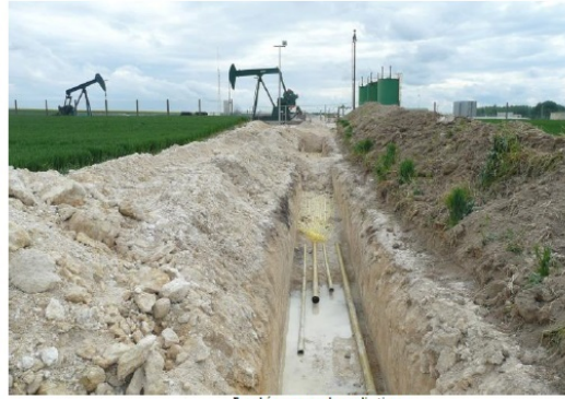
Figure 7 : travaux de pose des collectes
