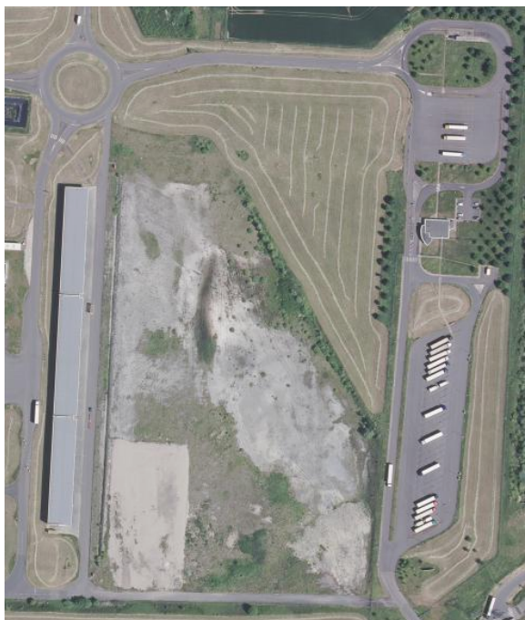
Figure 2 : Zoom sur les terrains concernés par la première phase du projet (source : géoportail)
