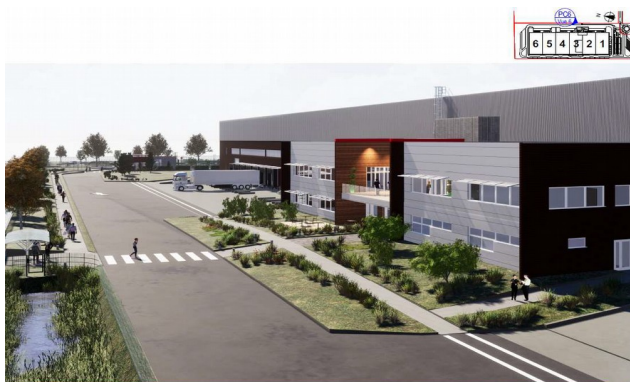
Figure 4: vue extérieure du bâtiment entrepôt (source porteur de projet)
