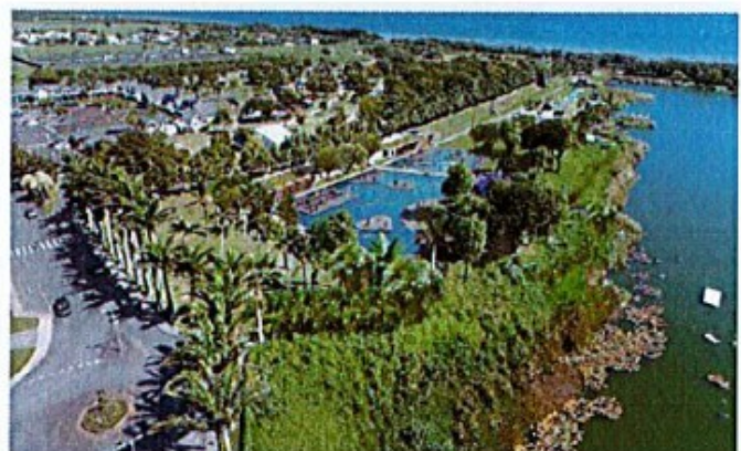
Création du bassin de baignade
