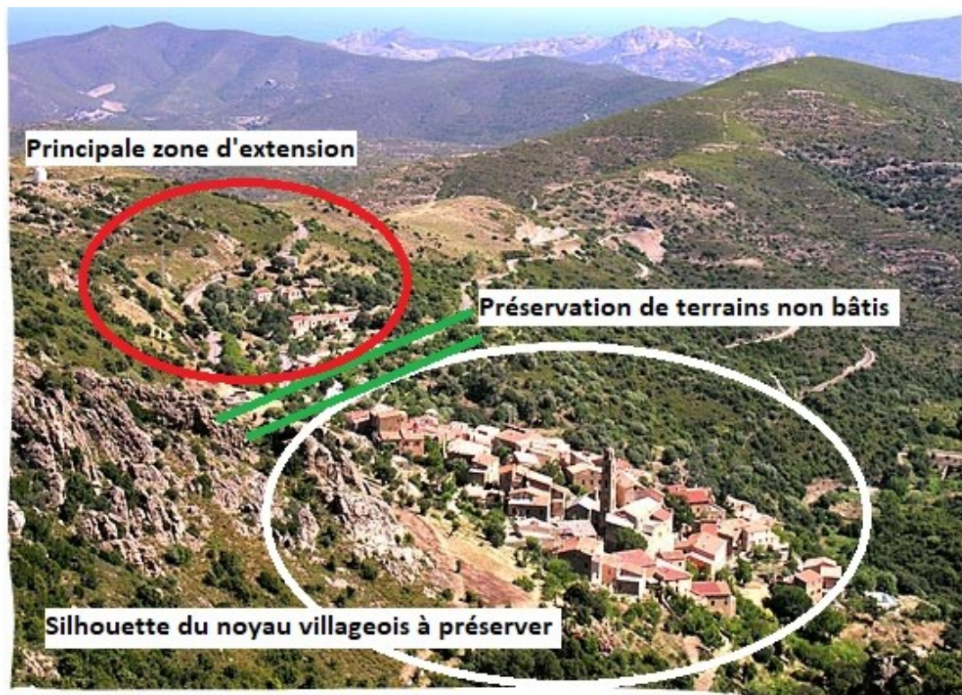
Illustration 3: Vue aérienne du village de Palasca avec au premier plan, le noyau villageois ancien et au second plan en continuité, les quelques constructions plus récentes au-dessus desquelles l'extension du village est envisagée par le projet de PLU
