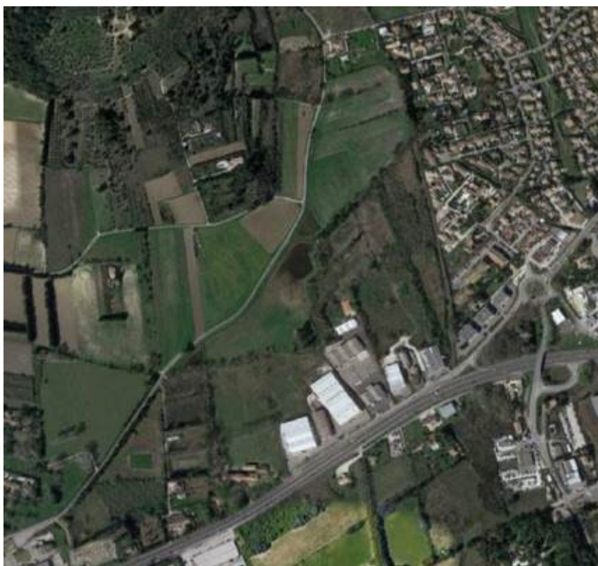
Figure 8: Vue aérienne de la Marquette et de son environnement proche - source : notice de présentation
