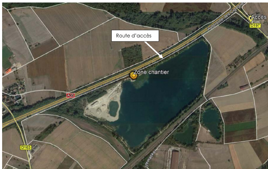
Figure 2: Le site tel qu'il est actuellement est formé d'un plan d'eau de 28 ha et d'une carrière en cours d'exploitation de près de 6 ha - source dossier
