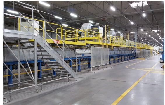
Installation de refroidissement du verre
