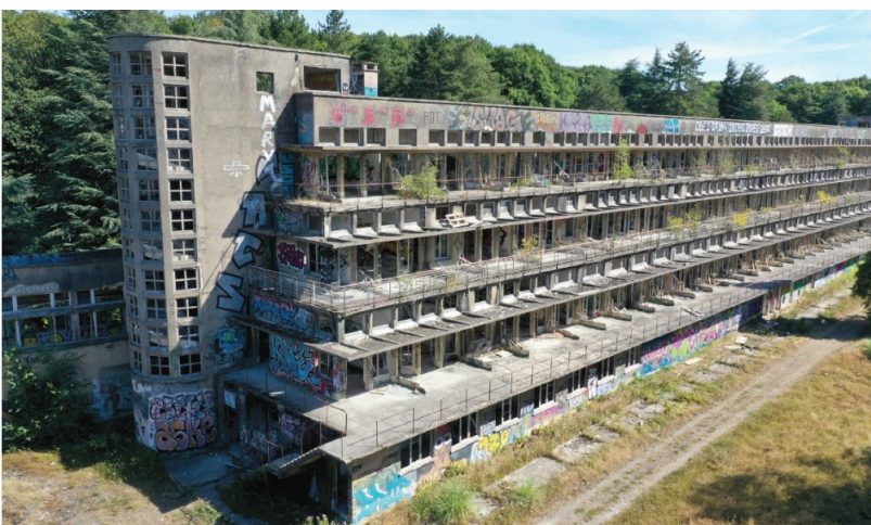
Figure 4: Le pavillon des Tamaris en juillet 2021 (angle sud-ouest du bâtiment B) (source : dossier de permis de construire, PC7-PC8, p. 10)
