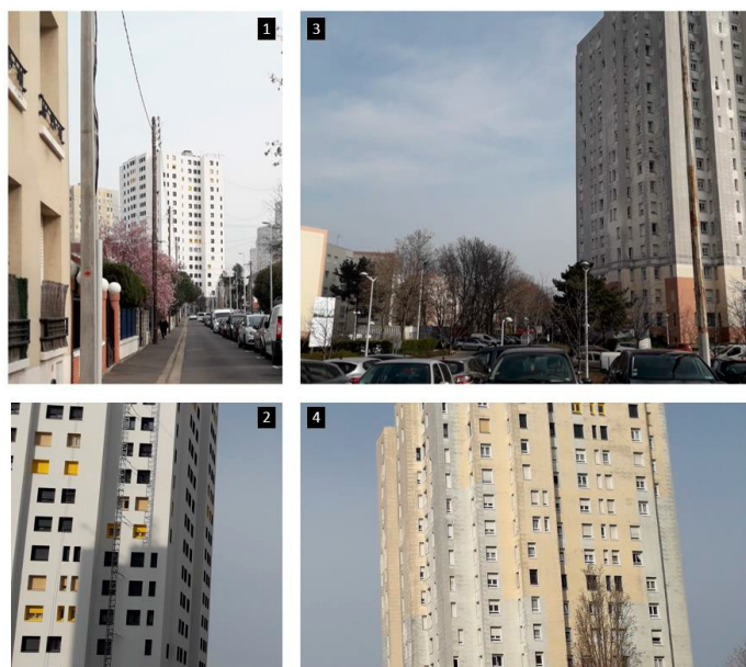
Illustration 8 : Tour réhabilitée (1 et 2) et tour originale (3 et 4). Source : Étude d'impact, p. 24 du volet 2.
