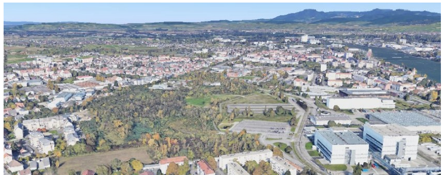
Figure 2: vue aérienne de la zone 2AUe. Source : dossier
