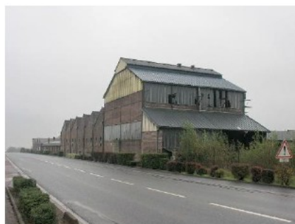
Figure 3: Bâtiment de la fonderie actuellement démolit. Source : dossier
