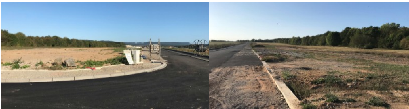
Vues au sud et au nord-est du site, depuis la voie de desserte aménagée en 2019
