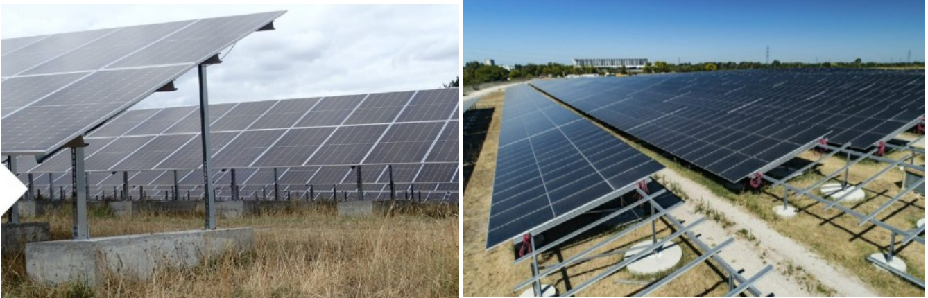
Figure 8: exemples de fixation de panneaux solaires sur d'anciens décharges (Source : site internet Valo Consult)
