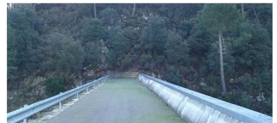
Figure n°5 : état actuel de la crête
