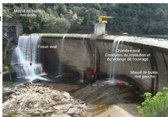
Figure n°8 : principales interventions sur le barrage
