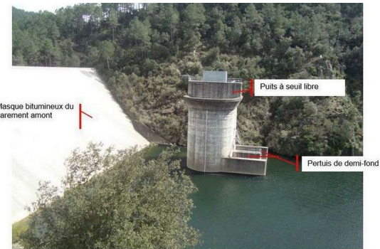
Figure n°3 : principaux organes du barrage
