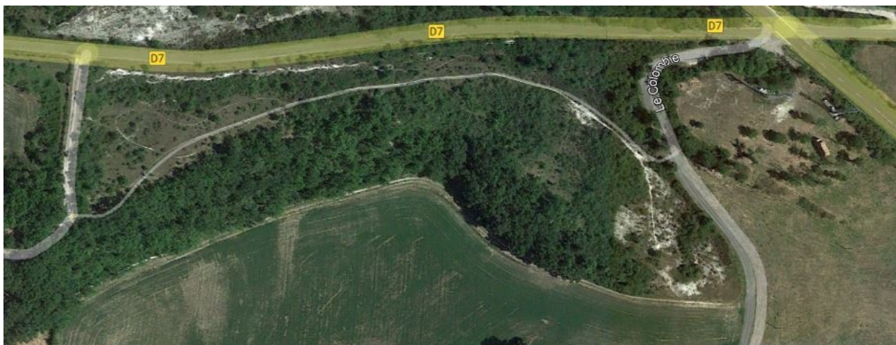
Photo aérienne du site du projet de juillet 2019 avant les travaux de terrassement et de défrichage (source Google Earth)
