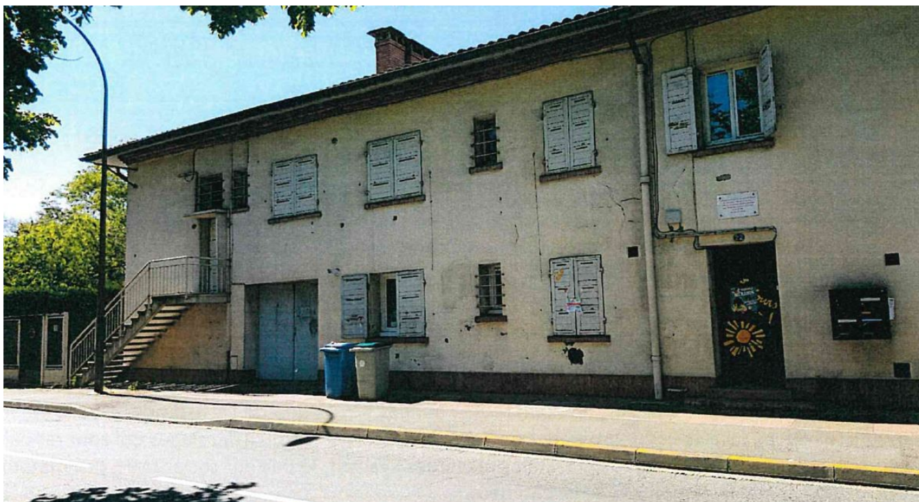
Façade du bâtiment à démolir
