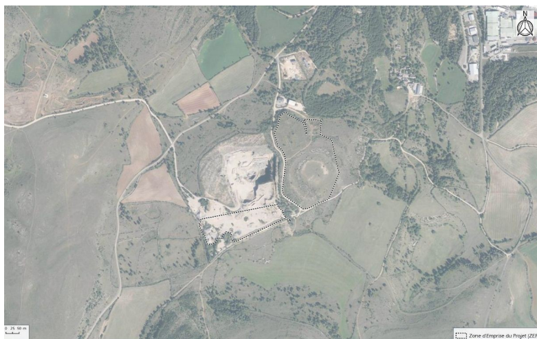
Figure 5: Localisation de la zone du projet de centrale jouxtant la carrière – Source : RP p.6
