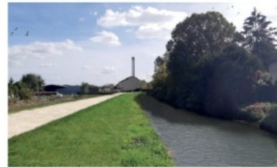
Digue Bas Trévois
