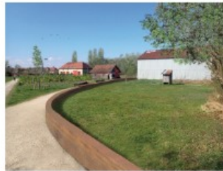
Digue du Parc des Moulins
