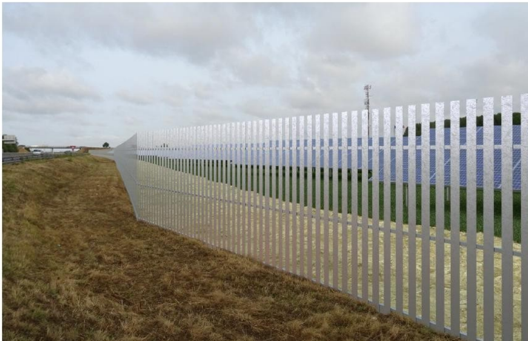
Figure 6: Bardage anti-éblouissement mis en place le long de l'autoroute (source : étude d'impact, page 149/181)
