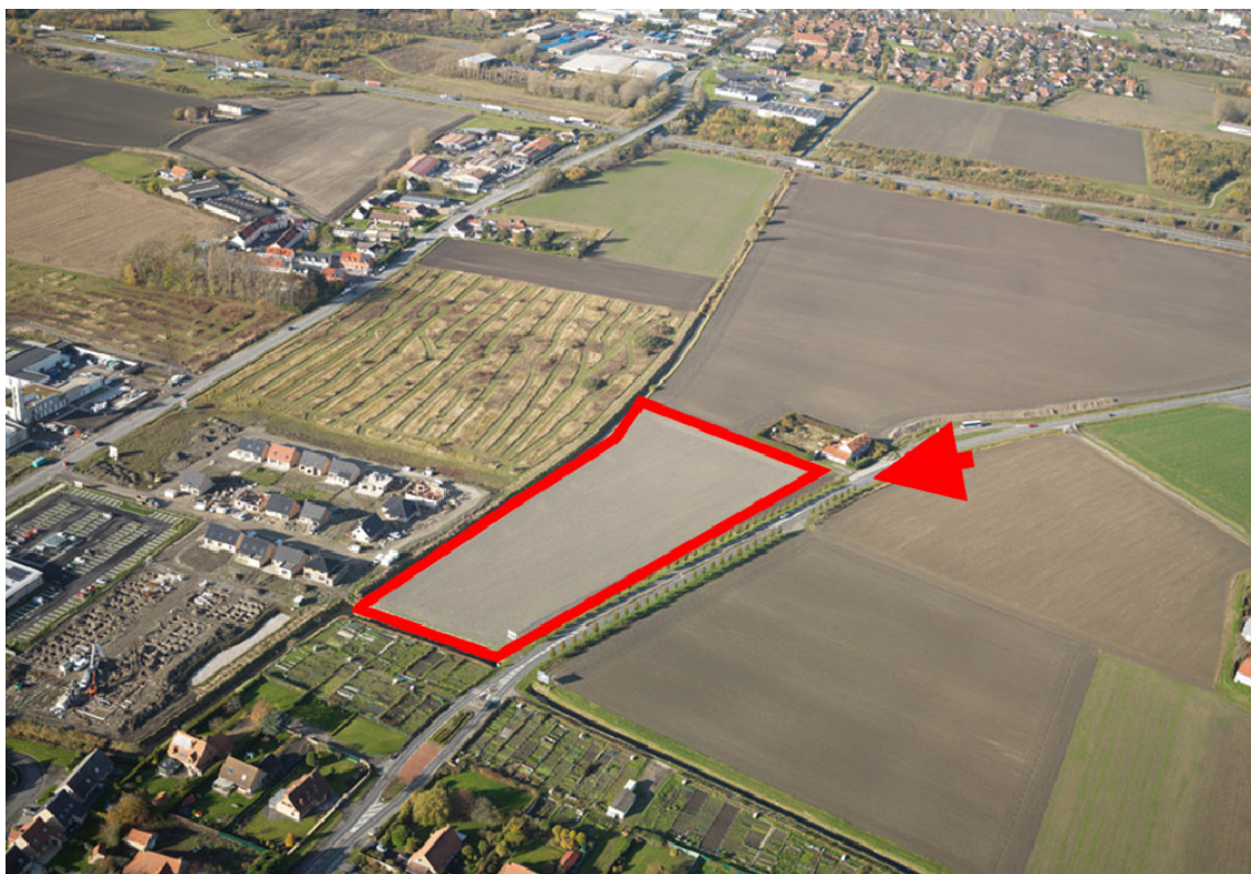
Photo extraite de la pièce n°9a du permis d'aménager montrant l'avancement des travaux de la zone (à gauche les bâtiments communaux, le Lidl et la première phase du lotissement déjà réalisés ou en cours – en rouge la zone du lotissement des Anthémis II B objet du permis d'aménager en cause)
