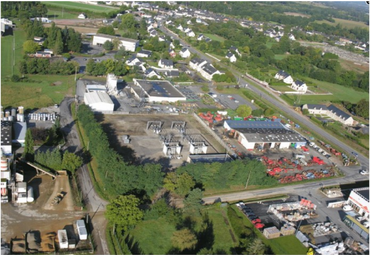
Figure 89 : Vue aérienne du poste source de Malestroit
