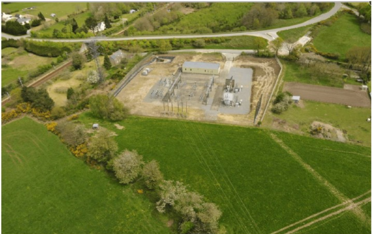
Figure 90 : Vue aérienne du poste de Questembert
