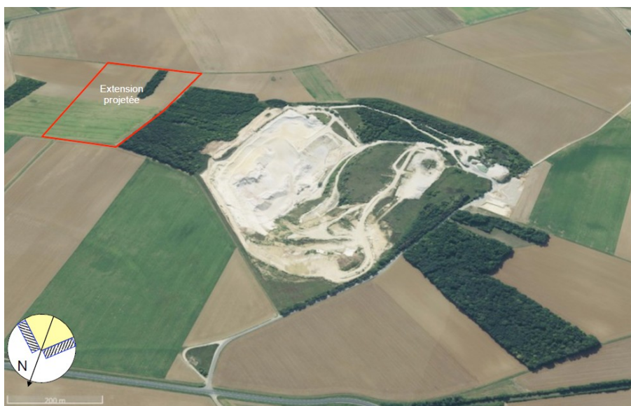
Illustration 3: Site actuel de la carrière et extension prévue (Source : dossier, pièce n°2.2, p.4)
