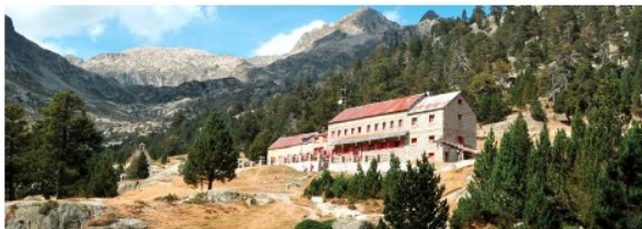
Façade sud : État actuel
