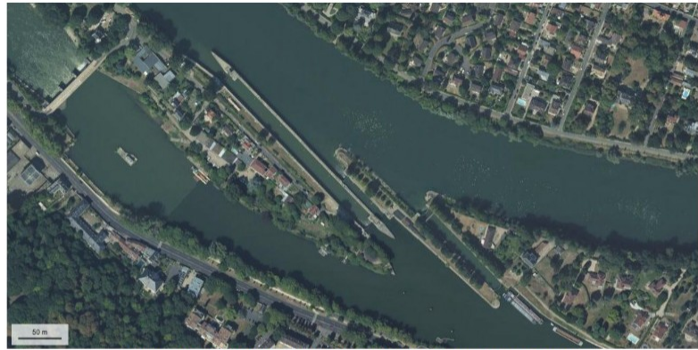
Figure 3: Vue aérienne avec le barrage de Bougival (source : Géoportail).
