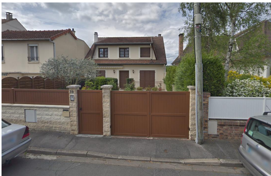
Vue depuis la rue de Cerisaie sur la construction individuelle grevée par cet emplacement réservé n°22
