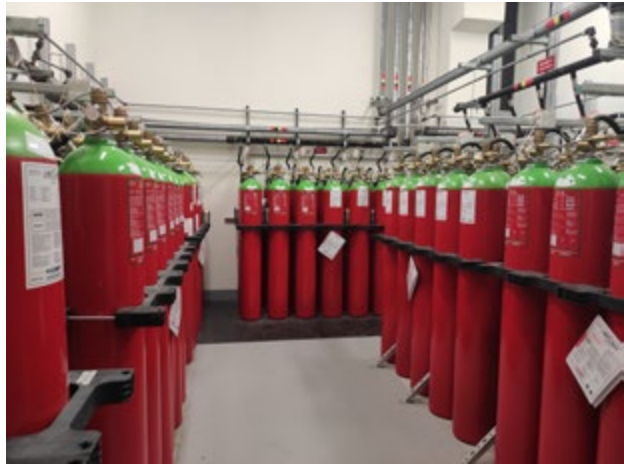
salle de stockage des dispositifs d'extinction d'incendie à La Courneuve/ @MRAe-IdF
