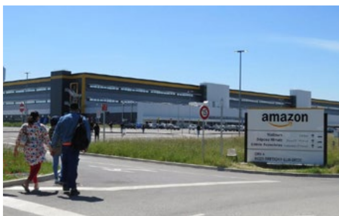
Le centre de données Amazon qui devait s'implanter à Brétigny-sur-Orge suspendu pour non valorisation de la chaleur fatale /©Le Parisien
