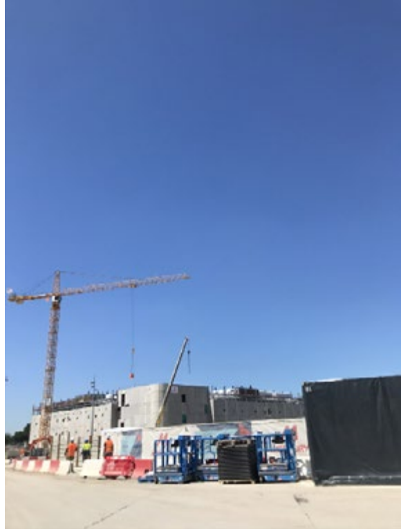
Campus Data Center à la Courneuve (93)/©MRAe
