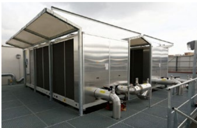
Toits du centre de données de La Ville Paris, qui contribuent à la valorisation de la chaleur fatale en la réinjectant dans le réseau de chaleur urbain/ @Ville de Paris
