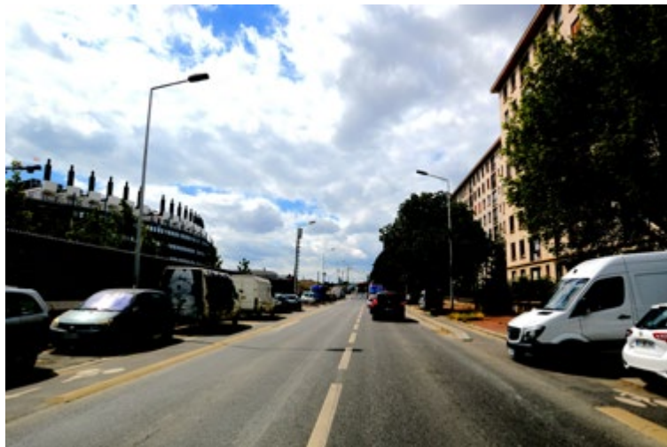
centre de données d'Interxion en cours de construction à La Courneuve, proximité des immeubles d'habitation, source MRAe Île-de-France 2021
