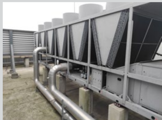
centre de données d'Interxion à La Courneuve, protection phonique en terrasse pour atténuer les nuisances sonores des systèmes de refroidissement. (source MRAe)
