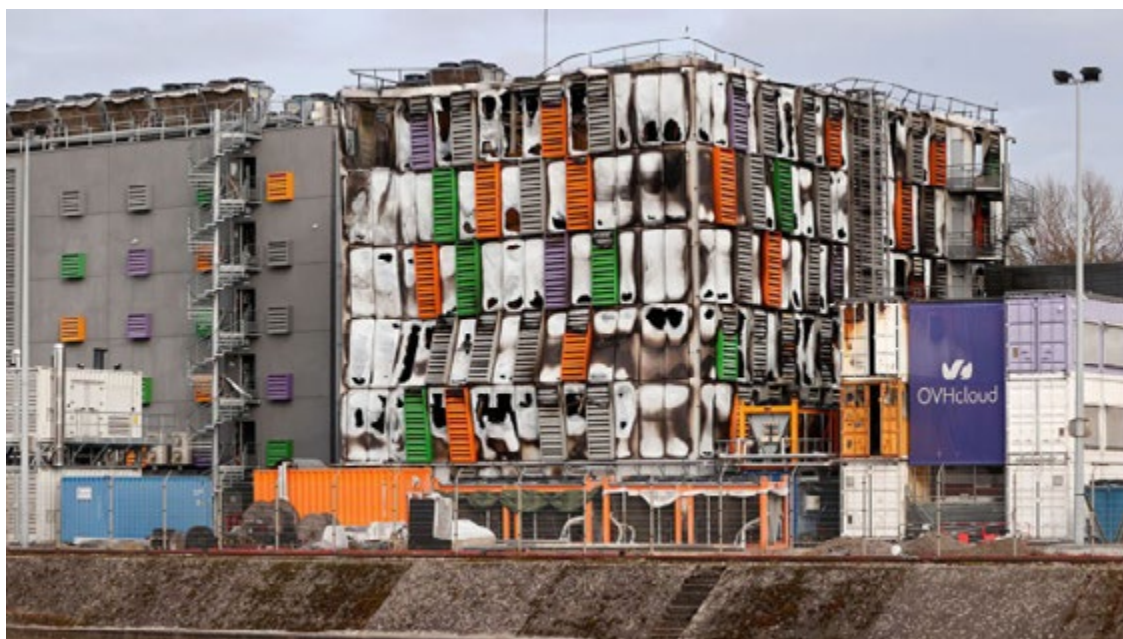
Centre de données OVHcloud de Strasbourg après l'incendie qui l'a endommagé en mars 2021 / ©LesEchos
