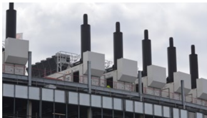
cheminées de sport des groupes électrogènes installés sur le centre de données en cours de construction à La Courneuve (source MRAe).
