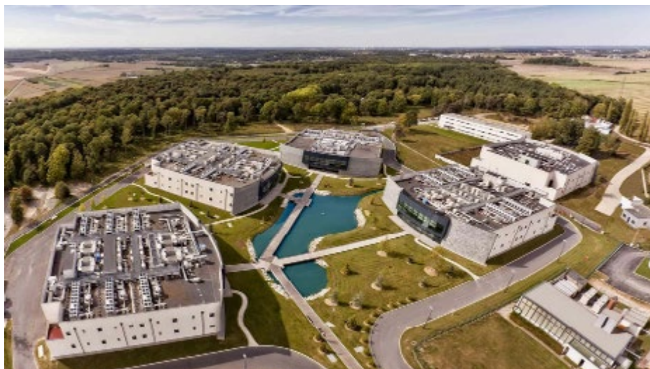
Le campus DATA IV de Paris-Saclay accueille déjà 13 centres de données sur son site ©Data4Group
