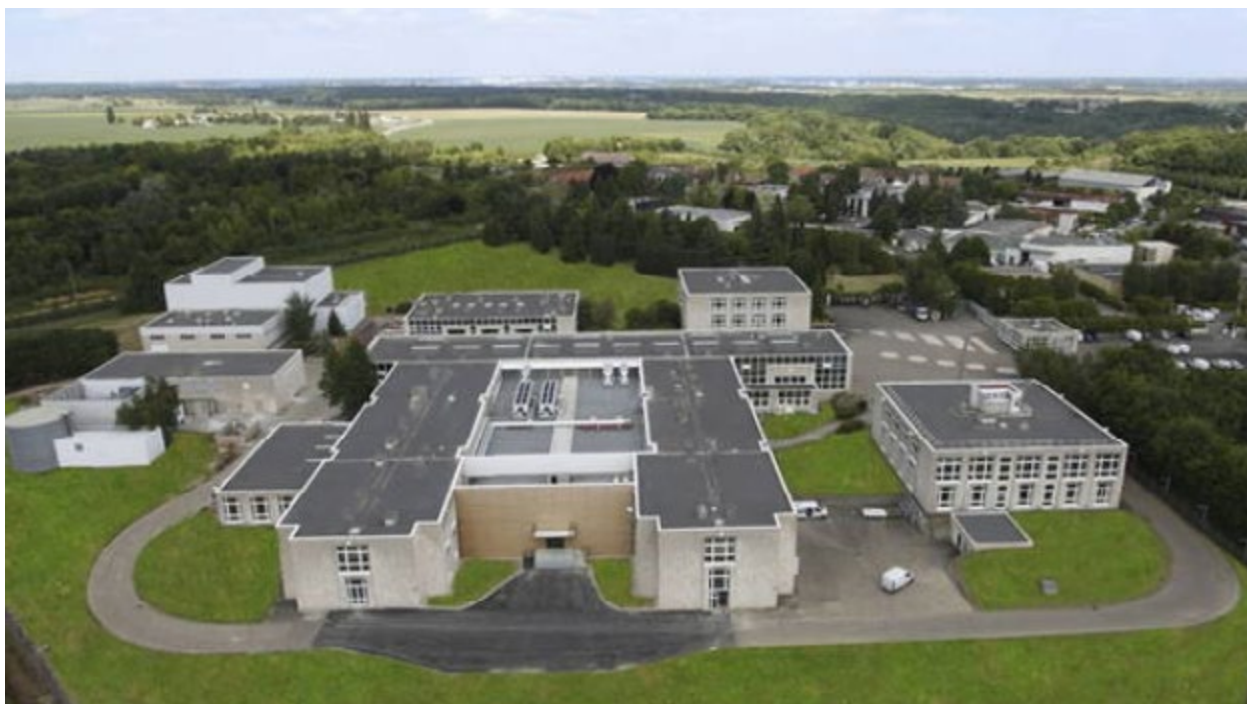
centre de données Téléhouse de Magny-les-Hameaux (78) source Baxtel
