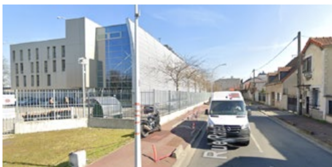
Data center rue du Rameau à La Courneuve ayant donné lieu au contentieux rappelé page 8 (source Google street 2021).
