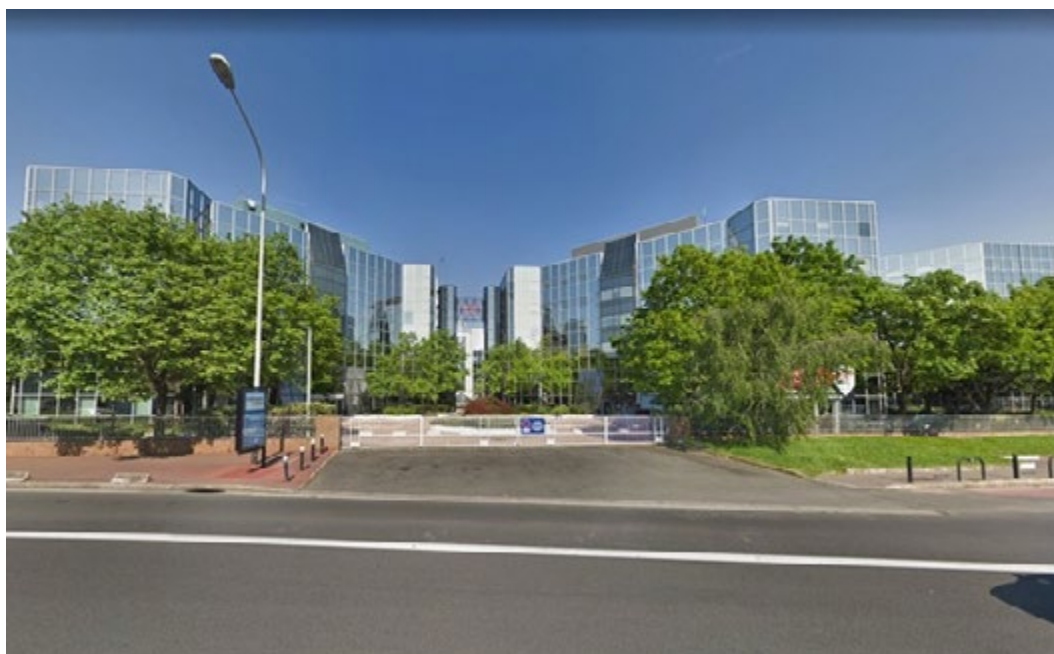
Centre de données PA7 d'Equinix à Courbevoie (Hauts-de-Seine) ©Baxtel
