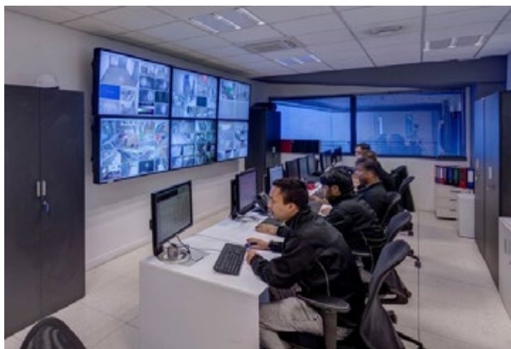
Centre de données PA4 de Pantin de la société Equinix, source Baxtel
