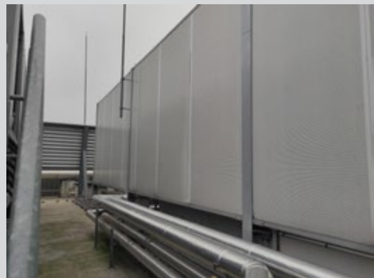
centre de données d'Interxion à La Courneuve, protection phonique en terrasse pour atténuer les nuisances sonores des systèmes de refroidissement. (source MRAe)
