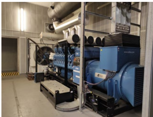
un des groupes électrogènes du centre de données Interxion à La Courneuve, source : MRAe-IdF
