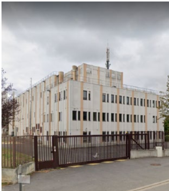
Data Center d'Orange à Meudon-la-Forêt (92) source Google street.
