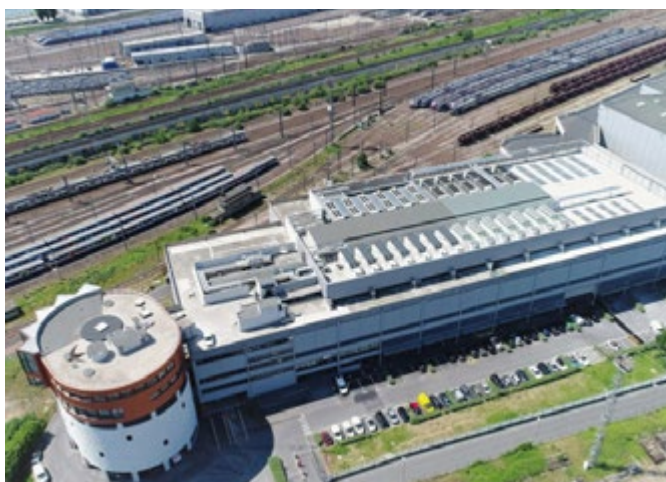
Centre de données Equinix à Pantin ©Baxtel
