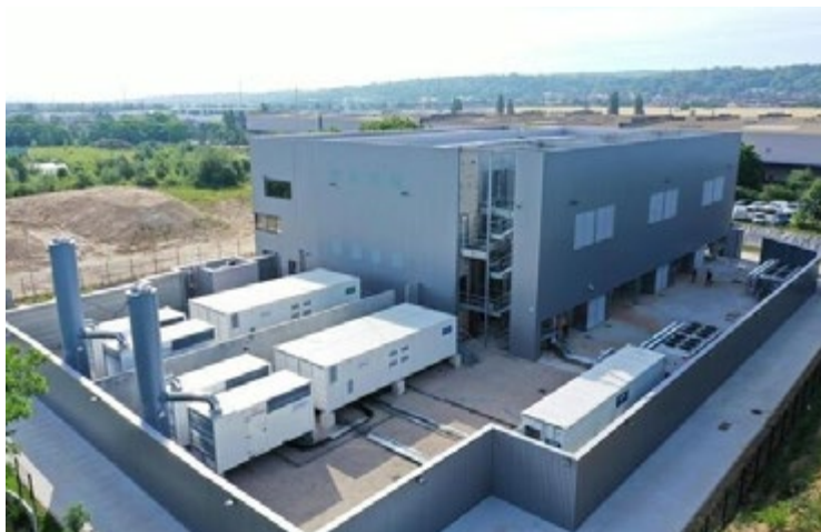
Centre de données PA4 de Paris-Pantin de la société Equinix, source Baxtel
