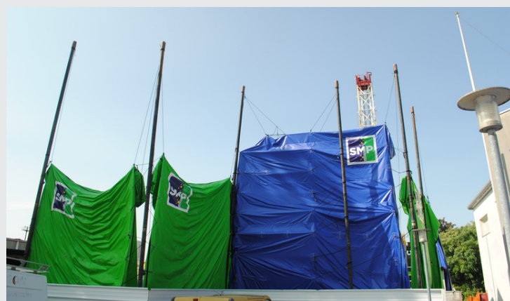
Protections anti-bruit déployées lors du forage de l'ouvrage géothermique ©MRAe IdF.
