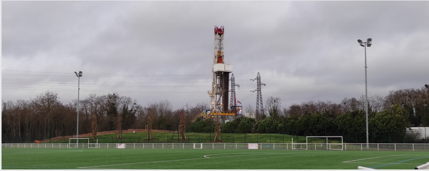
Lors du chantier, le forage de Ris-Orangis (91) dénote par son emprise paysagère importante, derrière le stade.
