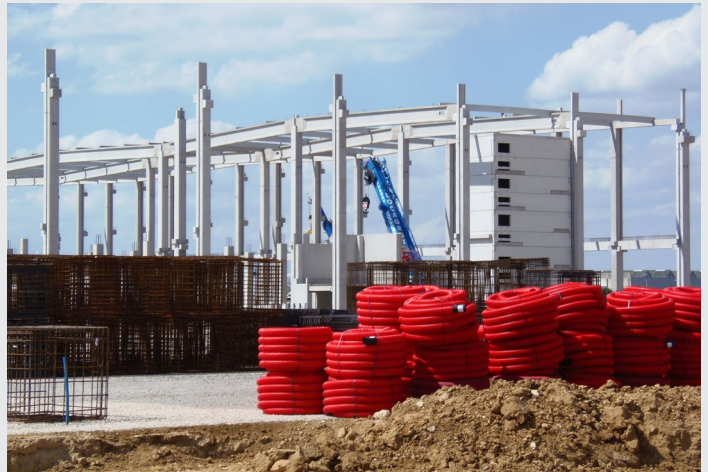
Construction d'un immense entrepôt dans le secteur de Villaroche (77) pour un des géants de l'e-commerce, source MRAe IDF, juillet 2022
