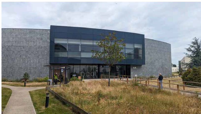
Le premier data center d'une série de 22 implantés sur le site de Marcoussis en Essonne par la société Data 4.
