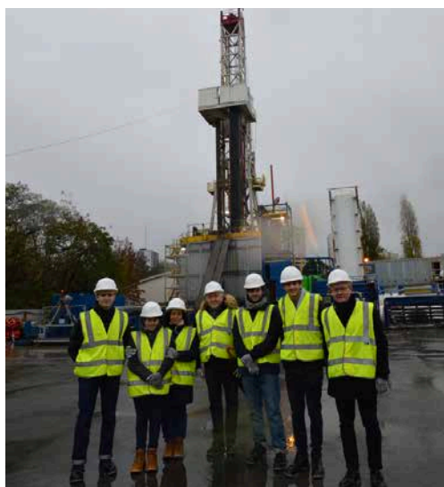
Visite par la MRAe du chantier de forage géothermique aux Lilas (93)
