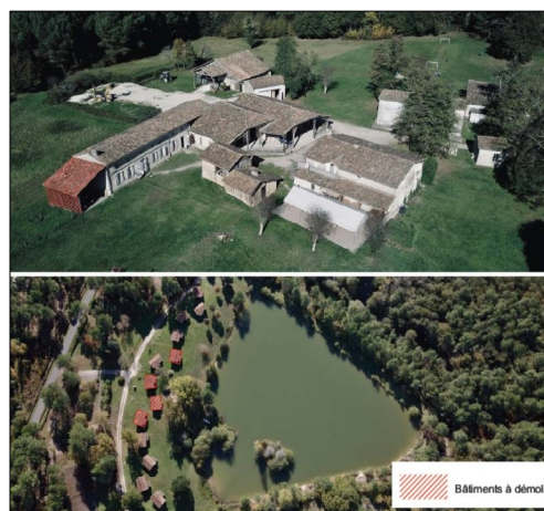
Bâtiments à démolir - extrait étude d'impact page 24
