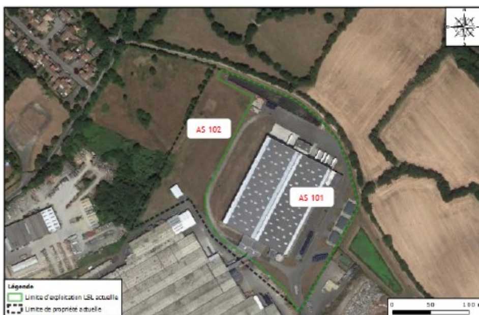
Photographie aérienne de la situation actuelle du site LSL (extraite du document de présentation générale page 11)
