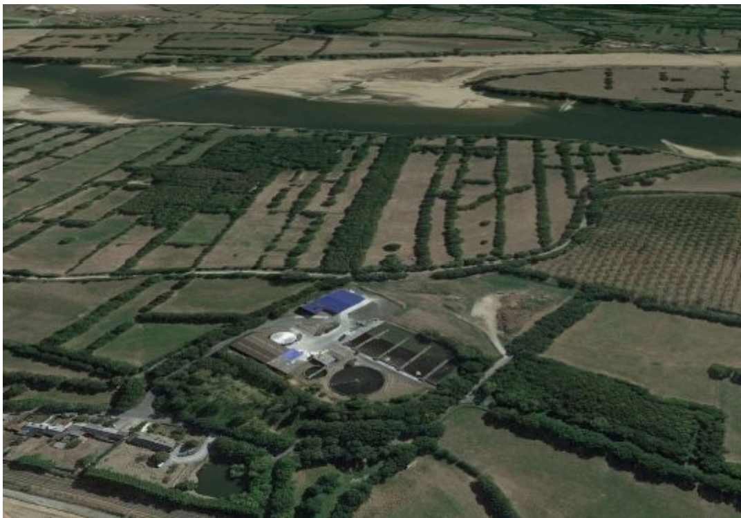
Station d'épuration actuelle vue du ciel (source google earth).
