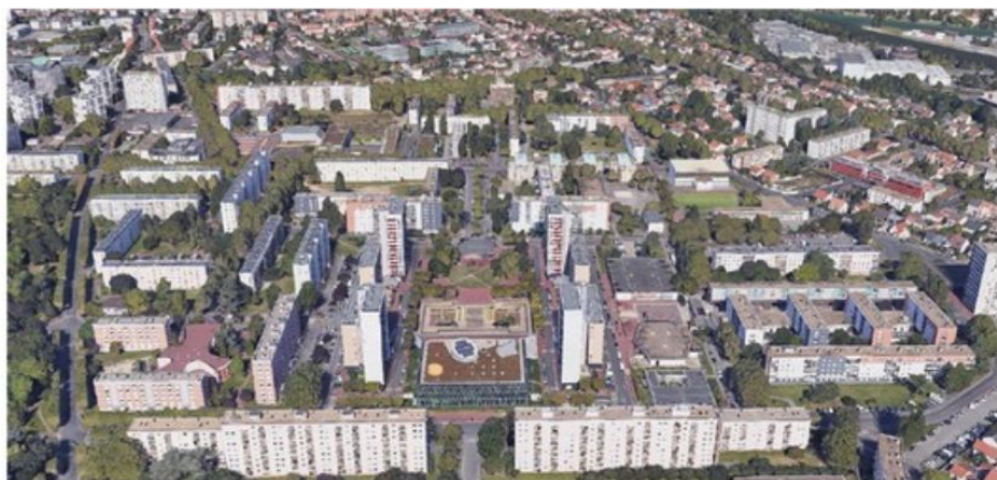
Illustration 14: Vue aérienne du site du projet du Haut du Mont Mesly Source : étude d'impact, première de couverture - vue vers le nord, avec au premier plan la médiathèque et la place de l'Abbaye
