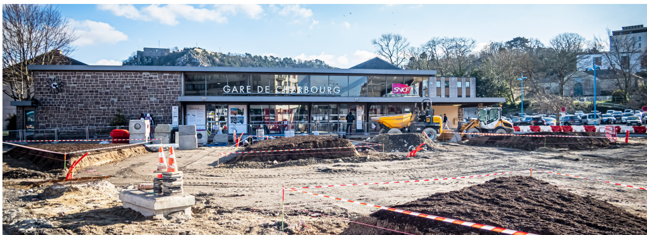
Chantier (2023) sur le parvis de la gare de Cherbourg-en-Cotentin (50) Christophe Cazeau / Terra
