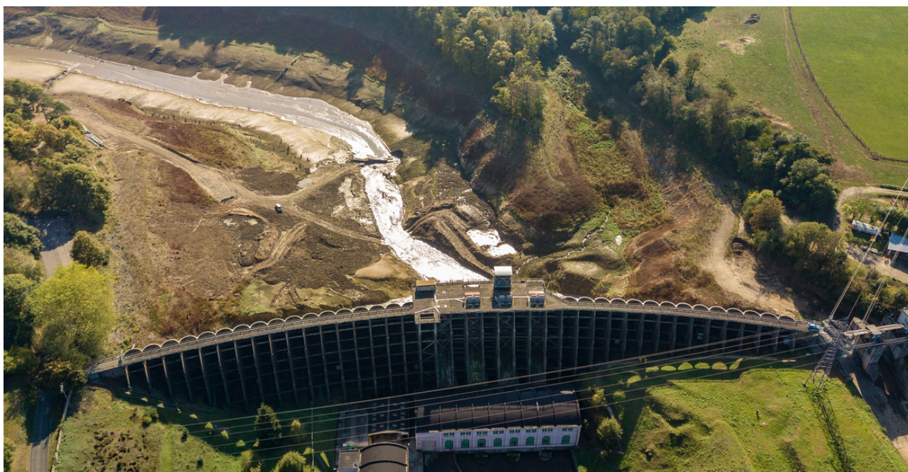
Vue aérienne - barrage de Veziens (50) - Dreal Normandie
