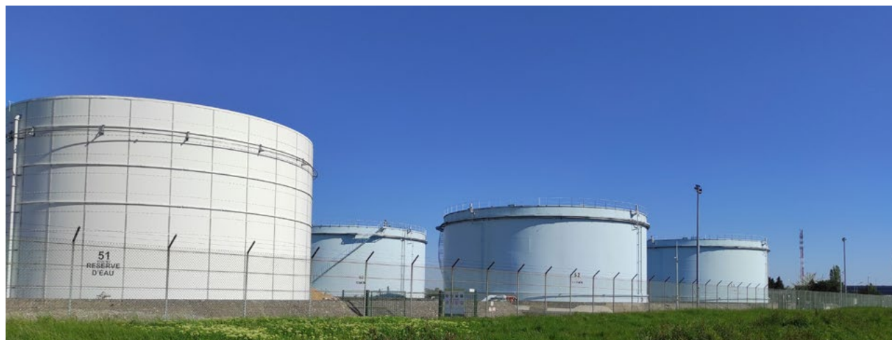
© MRAe, stockage SEVESO à Athis-Mons (91)
