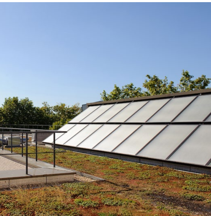
©Arnaud Boissou/TERRA. Panneaux solaires sur un toit végétalisé ( *Architecte : Agence Terreneuve)
