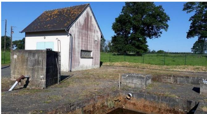
Figure 3 : Photographie du forage et de l'unité de déferrisation (source : étude d'impact)
