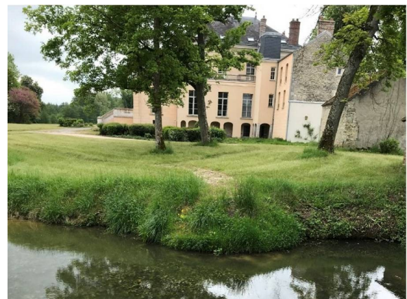
Figure 24 : Photographie du château (source : étude d'impact environnementale, p.156)
