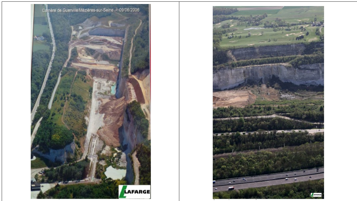
Illustration 8 : Photographies aériennes du secteur d’effondrement de 2001
