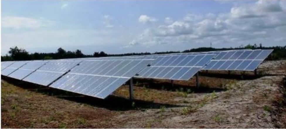
**Figure 17 : Exemple de centrale photovoltaïque équipée de panneaux fixes – technologie cristalline (couche épaisse)**
