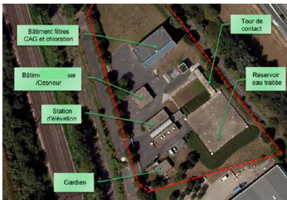
Illustration 1: vue aérienne de l'usine existante (source : étude d'impact, p. 13)
