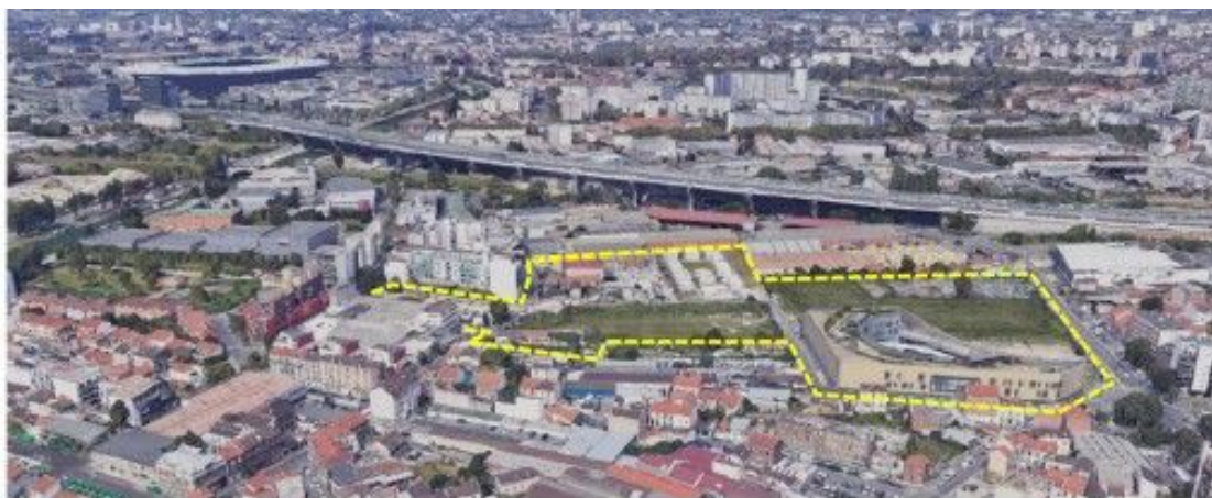
Fig 1. Vue générale du site du projet (source : étude d'impact)
