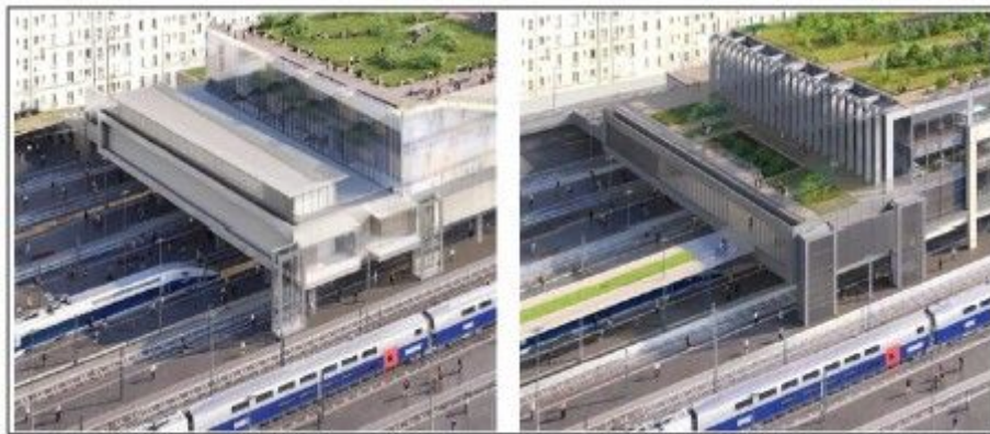
Illustration 3: Présentation de l'arrivée en gare de la passerelle Nord, en vert et parallèle aux rails sur l'image de droite (projet modifié) l'image de gauche illustrant le projet initial (source étude d'impact, p.46)
