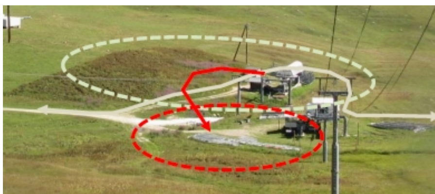
Figure 7 : Photographie des deux gares actuelles prise en août 2018. En rouge, l'emplacement regroupé pour les deux appareils. En vert clair, la zone réhabilitée en bordure du plateau pastoral. En beige, la liaison avec la piste d'accès reconnectée. Source étude d'impact.
