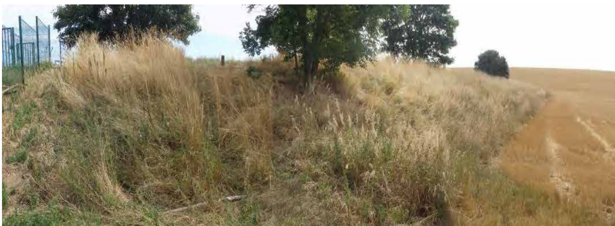
Fig. 4. Photographie du barrage en remblai (vue du talus aval rive gauche)
