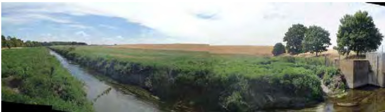
Fig. 3. Photographie de la cuvette, en amont de l'ouvrage de retenue
