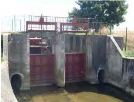
Vue aval de l'ouvrage de vidange
