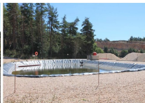
Vue sur le bassin de recueil des eaux pluviales de la piste principale servant à l'alimentation du réseau d'arrosage des pistes
