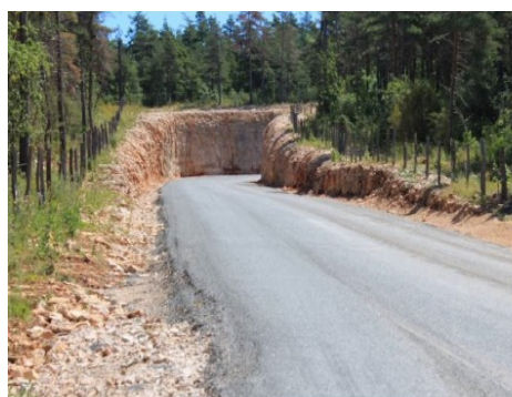
Vue sur la piste principale d'accès au site (en arrivée)
