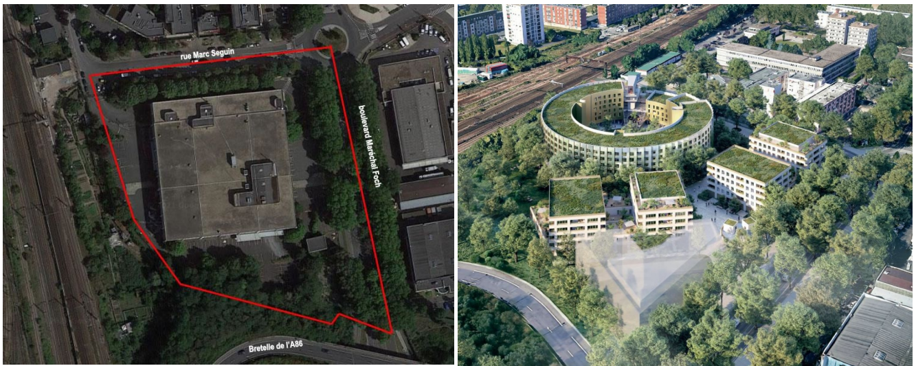
Figure 2: Vues du site de l'ancien tri postal et du projet (source: p. 85 et 86 de la notice de présentation)
